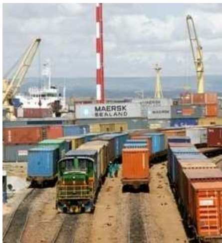
Tipico raccordo ferroviario tra Terminal e Porto
